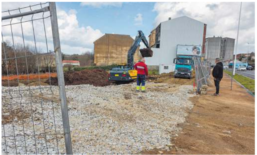
Movimiento de tierras para el restaurante frente al parque comercial de A Revolta. ANA GARCÍA
