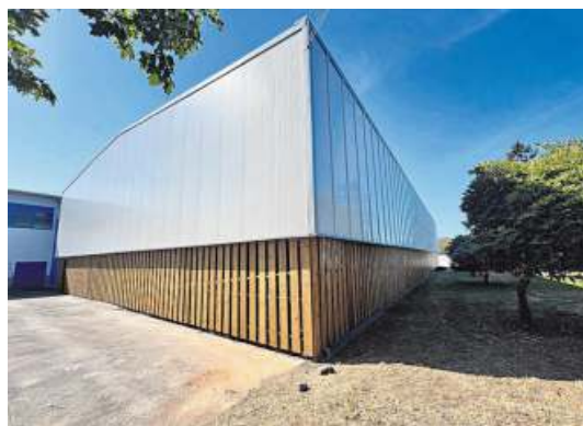
La reforma del pabellón escolar ya terminada.
