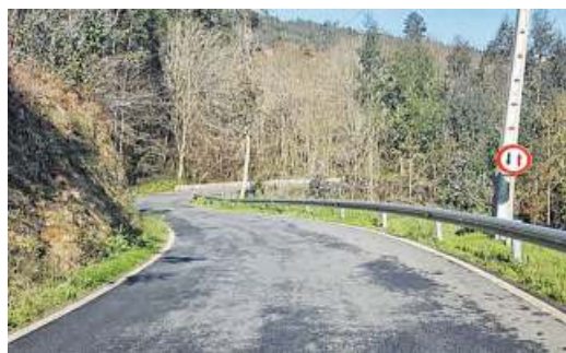
Lugar en donde se llevará a cabo la obra por parte de la Deputación.
