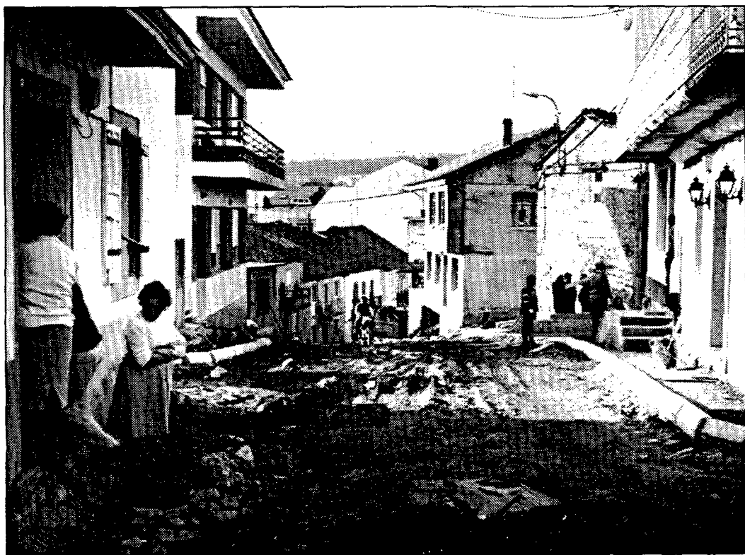
El ayuntamiento realizará nuevas actuaciones en vías de Ponte do Porto
